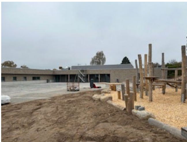
Baustelle des neuen Bürgerhauses (Stadt Ober-Ramstadt)
