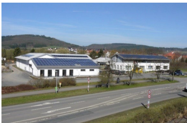
Dienstleistungszentrum und Bauhof mit PV- und Solarthermieanlagen (Fotos: Gemeinde Allendorf (Eder))
