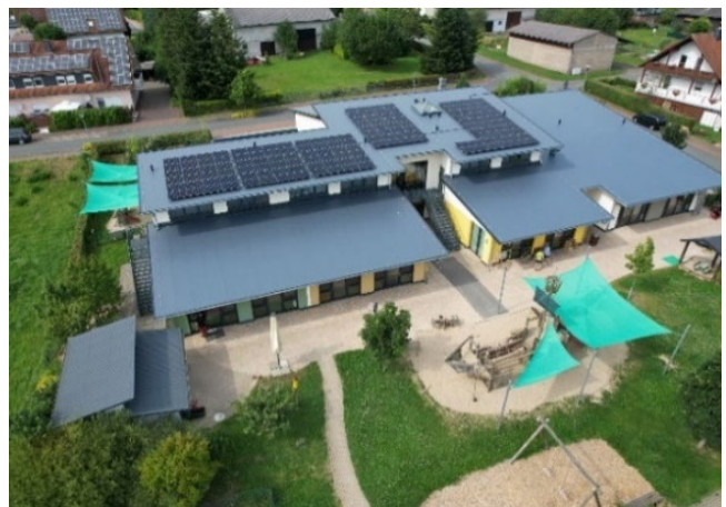
Kita Rennertehausen, neue PV-Anlage 2024 nach Dacherneuerung
