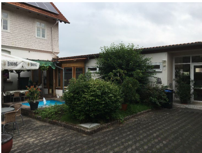
DGH Sterkelshausen vor der Sanierung (Gemeinde Alheim)
