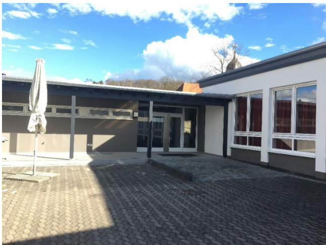
DGH Sterkelshausen nach der Sanierung (Gemeinde Alheim)
