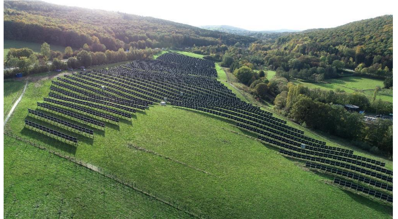
Agri-PV-Anlage in Dirmingen: 7 ha Grünland, 2 MW
