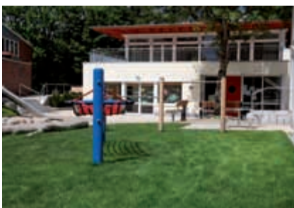
Umbau des Waschhauses durch die Gewoba zu Café, Büro- und Beratungsräumen, Medienwerkstatt, Veranstaltungs- und Kinderbetreuungsraum
