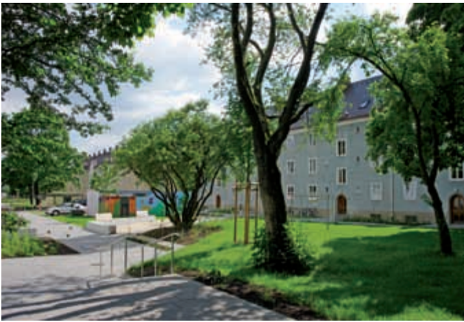
Umfangreiche Wohnumfeldverbesserungen: Rampen schaffen Barrierefreiheit
