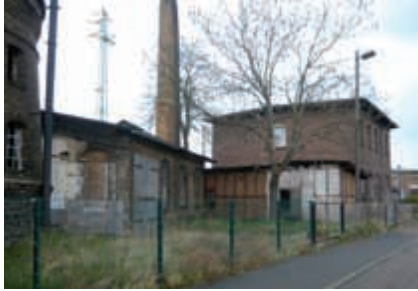
Gebäudeensemble vor Sanierung und Umnutzung 2006
