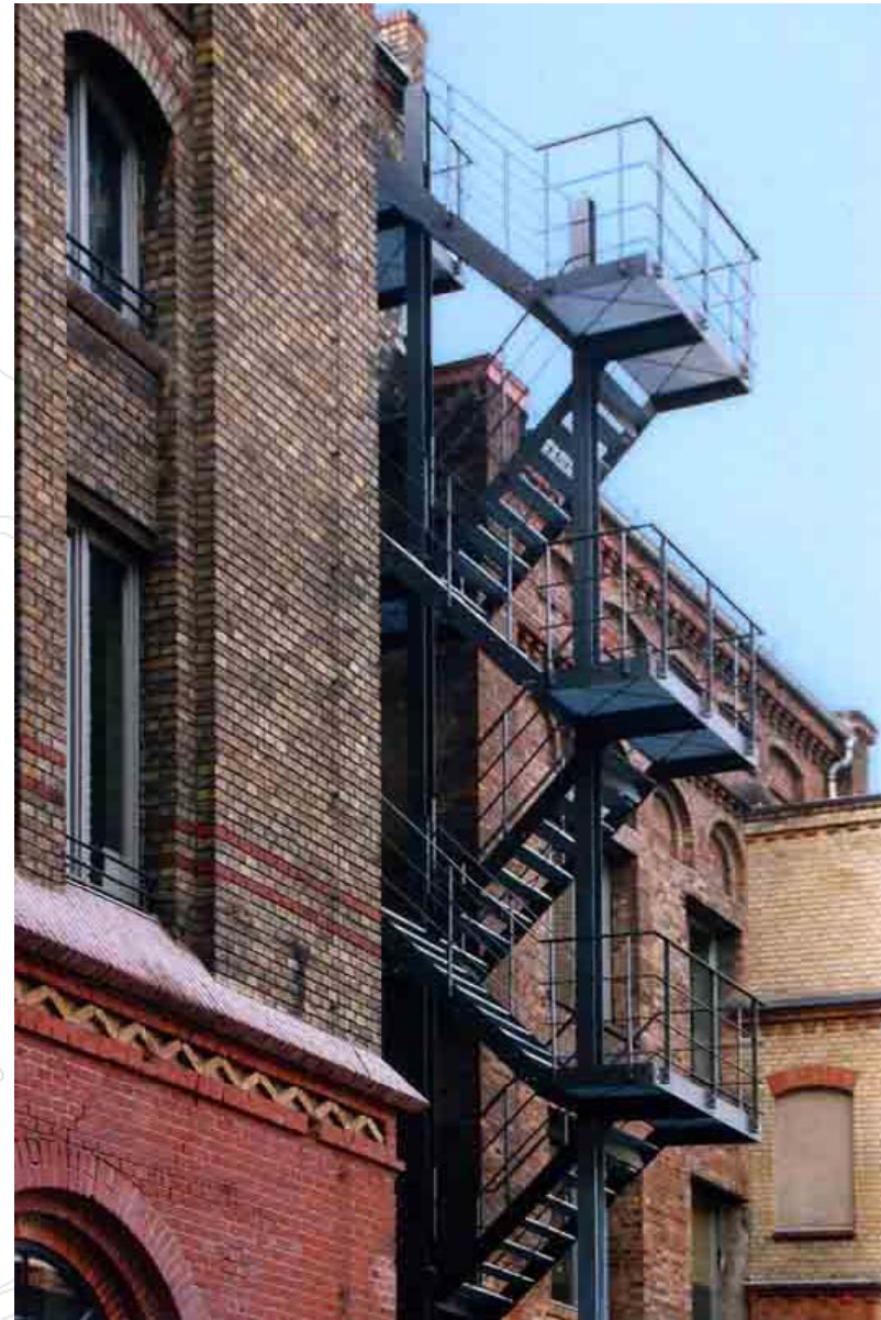
Haus C – Außentreppe
