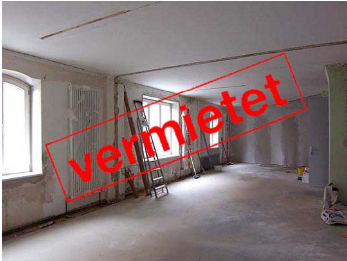
Haus B, 3. OG, im Ausbau
