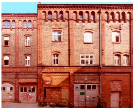
Haus B, Hof-Ansicht, vor und nach der Sanierung
