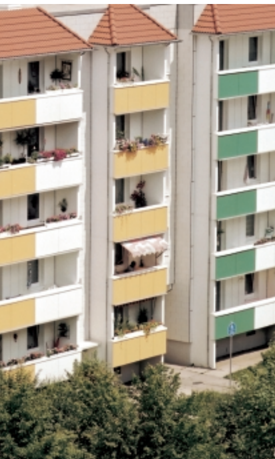
Sanierte Wohnsiedlung an der Stuttgarter Allee in Leipzig
