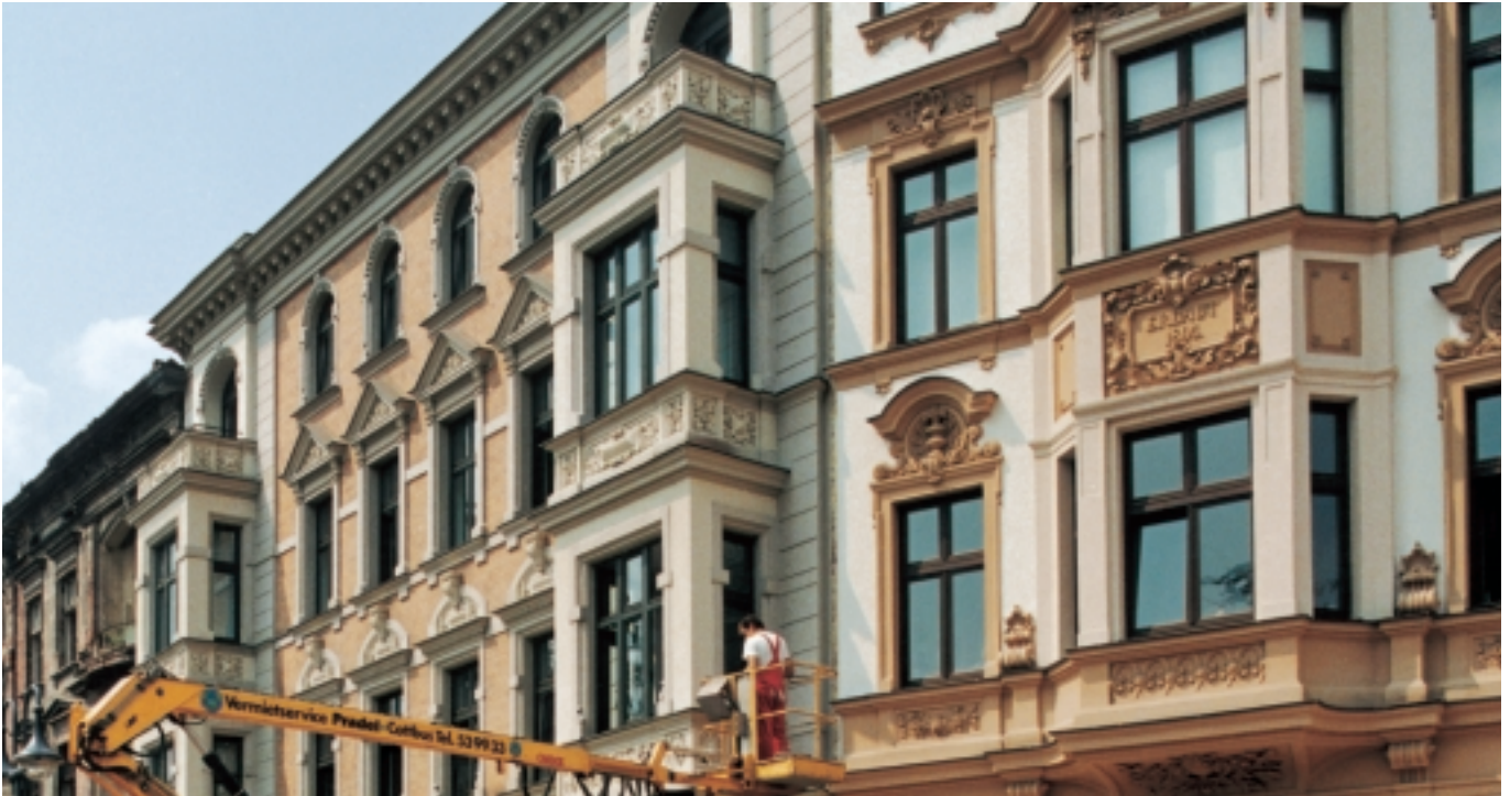
Altbausanierung am Ernst-Thälmann-Platz in Cottbus
