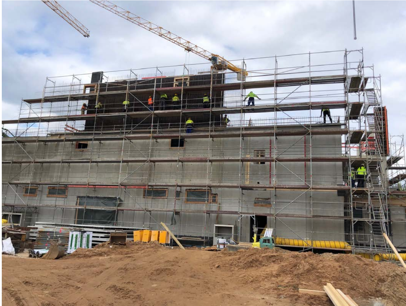
Rohbau RZ Webhouse
