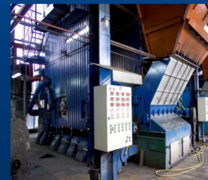
4 Wasserrohrkohlekesseln WR-10 mit der Gesamtleistung von 50 MW.W
